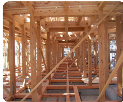
建築中の様子
